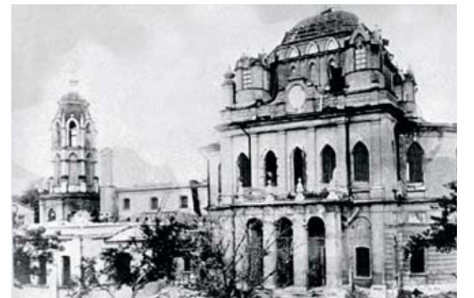
Начало разрушения Богородице-Рождественского собора монастыря, 1933–1934 гг.
